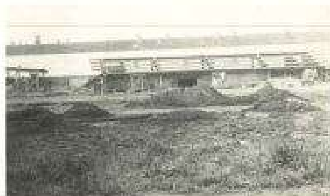
Arquibancadas quase prontas.
